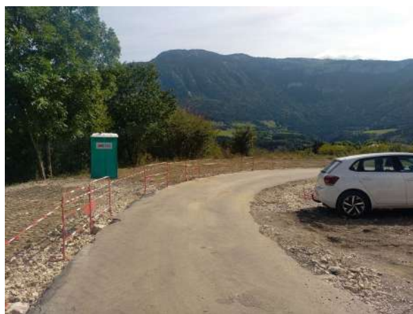
Travaux de réaménagement du parking des Aigaux
