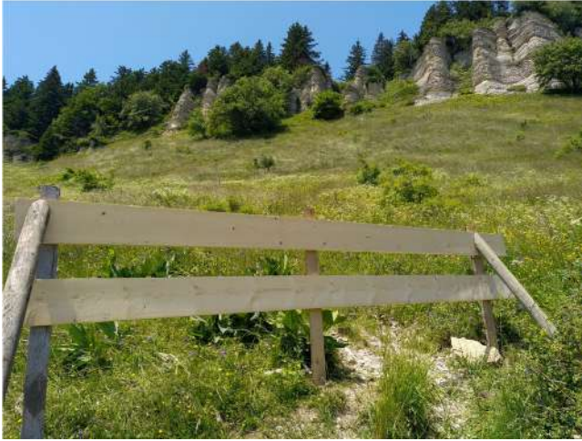
Pose de chicanes avec Etienne Bessaguet, écogarde, à La Molière pour empêcher les personnes de couper le sentier et ainsi limiter l'érosion.
