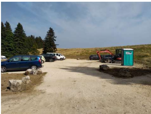
Travaux de réaménagement du parking de la Molière
