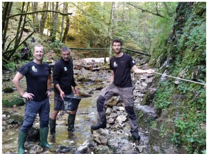
Chantier collectif à trois écocardes pour pose d'une « ligne de vie », remettre le sentier en état et tronçonner les embâcles sur le cours d'eau.
